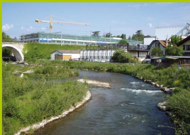
Después de la restauración
