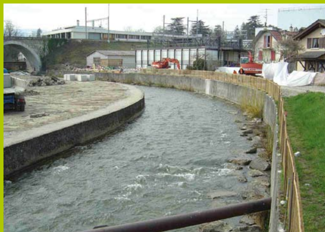
Antes de la restauración
